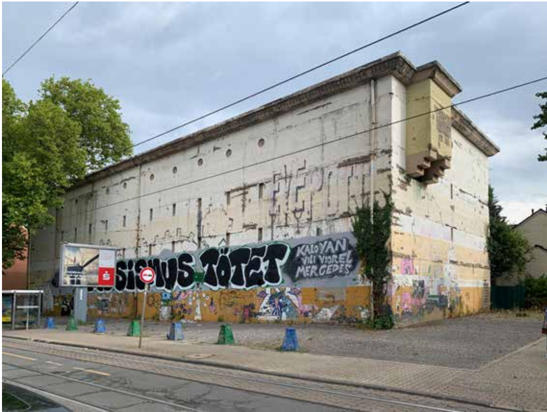
Abb. 1: Bestandsaufnahme des Bunkers.
