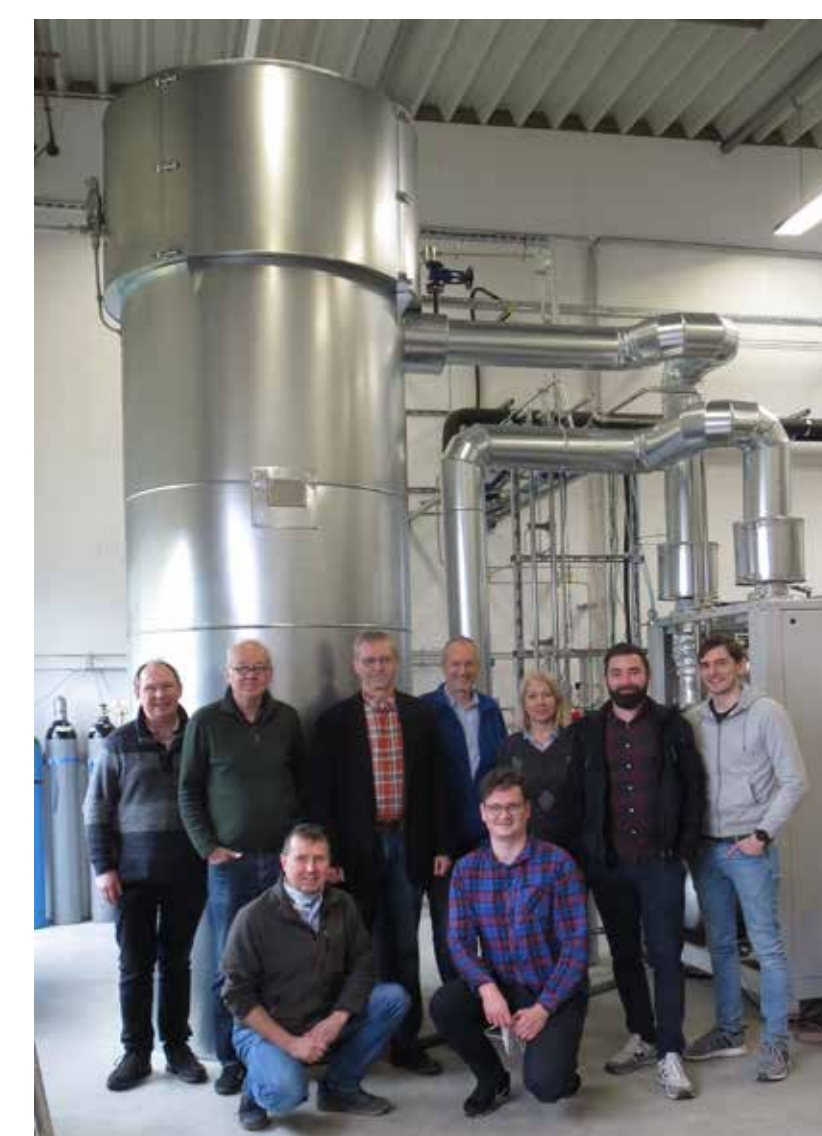
Abb. 4: Teile des Projektteams von iuta, MPI und WH vor dem Wärmespeichersystem.
