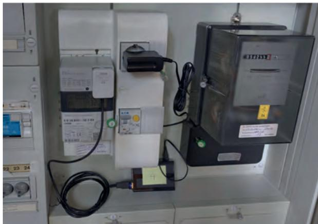
Abb. 2: Installation eines neuen elektronischen Haushaltszählers (eHZ) nach gesetzlichen Vorgaben (links) neben einem klassischen Ferraris-Zähler (rechts). Am eHZ ist bereits die Auslese- und Auswerteeinheit angeschlossen.
