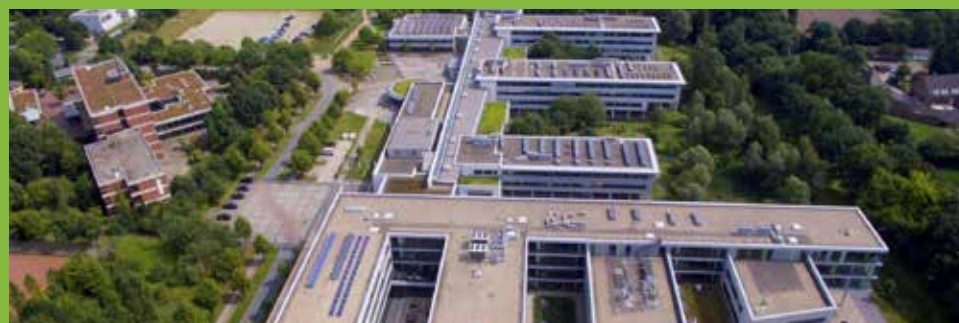
Abb. 21: Photovoltaikmodule auf den Gebäuden am Standort Gelsenkirchen (auch Dachflächen mit Dachbegrünung sichtbar), Foto: Drohnfoto WH
